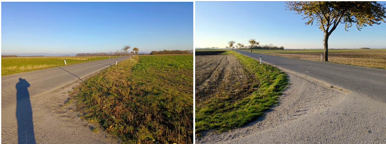
Abbildung: Sichtverhältnisse, Kreuzung mit der L 3008 (von Süden kommend) – Blickrichtung Ost (links) und West (rechts)
