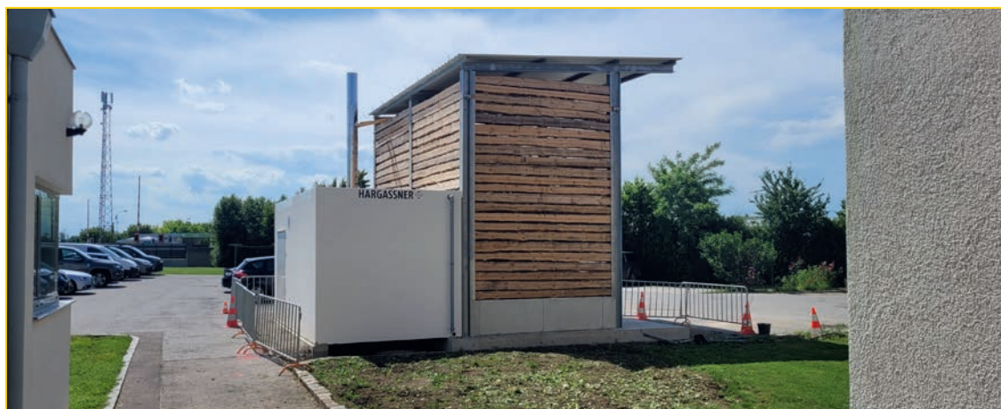
Hackgutlager der Straßenmeisterei Bruck/Leitha
