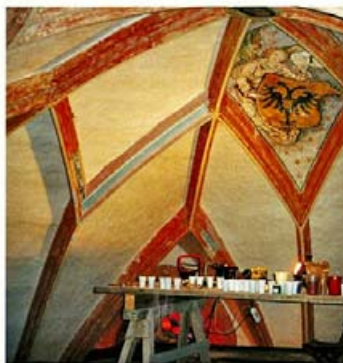
Ehemalige Klosterkirche Pernegg, Freilegungs- und Restaurierungsarbeiten an den Chorgewölben
