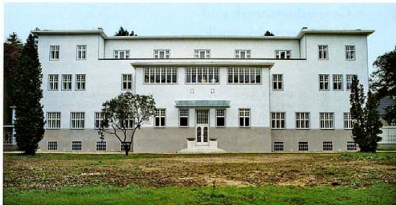
Sanatorium Parkersdorf, Ansicht von Osten nach Ab- tragung der Aufstockung
