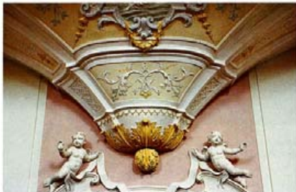
Emporen-Fuß nach abgeschlossener Restaurierung
