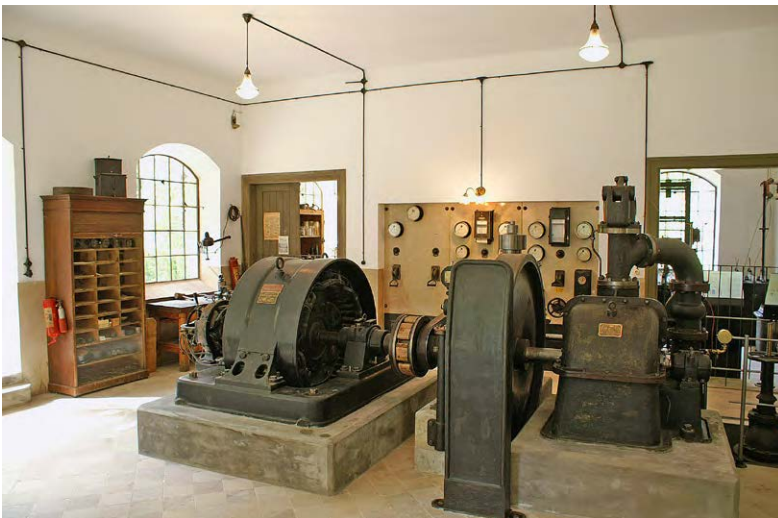
Elektrizitätswerk aus Fürstenbrunn von 1913 im Salzburger Freilichtmuseum
