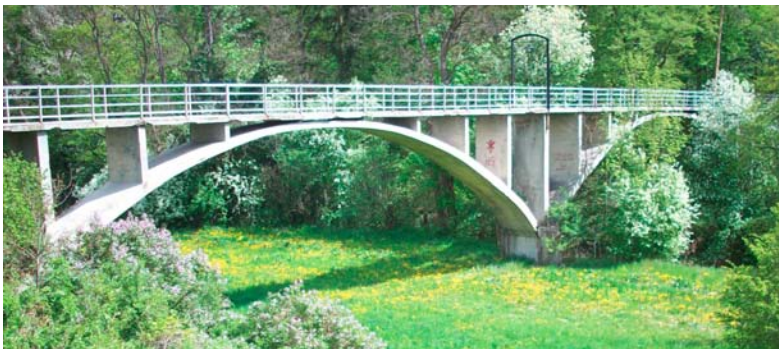
Horn, Piaristensteg, erbaut 1937 von Dr. Emperger
