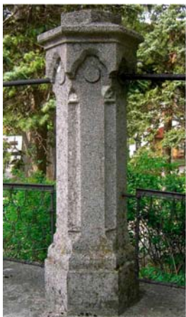
Sockelmauer der Kirche in Weissenbach, originale Schalungsabdrücke an der Seitenwand (unten rechts)
