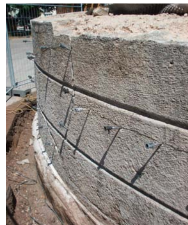
Gestockte Sockelmauer während der Verpressung 2009
