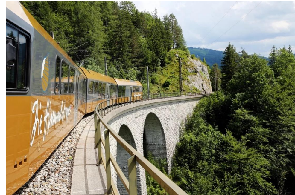
Garnitur „Himmelstreppe“ der Mariazellerbahn © Niederösterreich Bahnen GmbH
