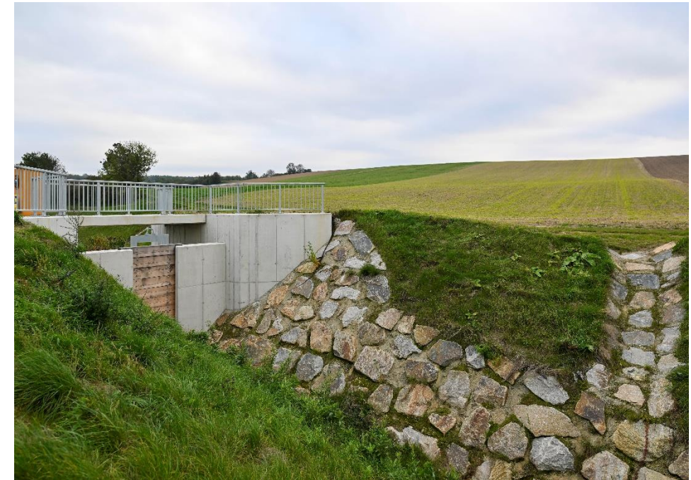
Beispiel einer Hochwasserschutzanlage © NLK Filzwieser
