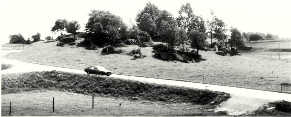
ANSICHT VON NORDEN
