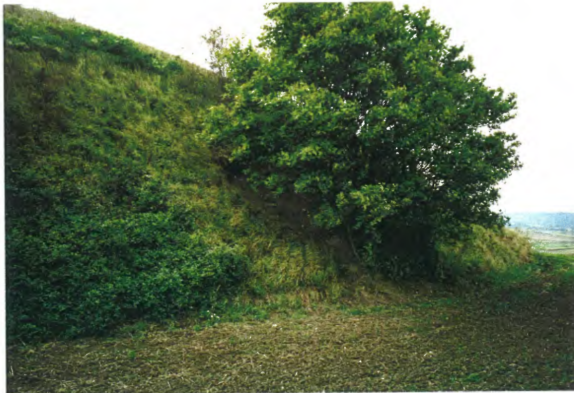
Verbuschung im Fußbereich
