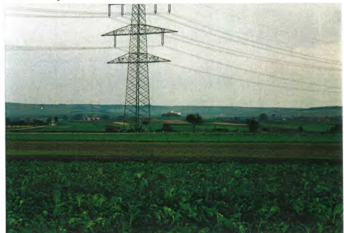
Beeinträchtigung der Wirkung des Leeberges durch Strommast und Silo
